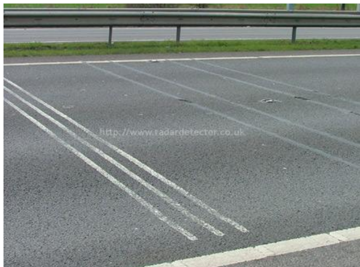
Obrázek 4 Umístění párů piezoelektrických senzorů
