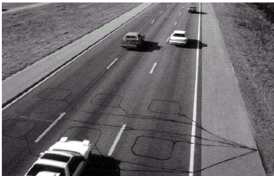
Obrázek 7 Instalace indukčních smyček
